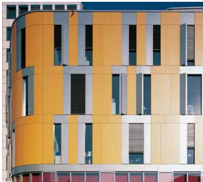
Kreishaus Aachen, Aachen, Deutschland | Administration Building, Aachen, Germany Heuer Faust Architekten | © www.rs fotografie.de
